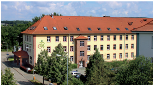
ZAR Kaiserslautern – ZAR für ambulante Rehabilitation
