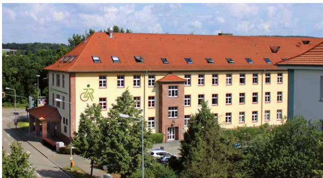
ZAR Kaiserslautern – ZAR für ambulante Rehabilitation
